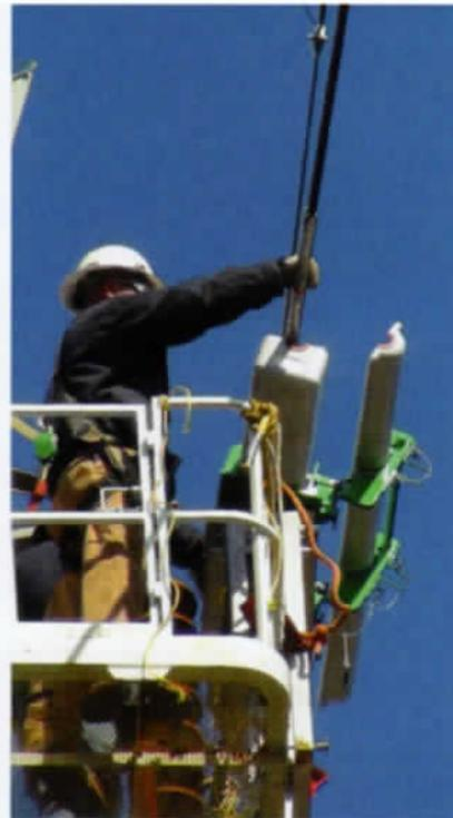
Bild 3. Die Montage der Geräte ist einfach: in einer Stunde lassen sich sechs Module auf einer abgeschalteten Leitung mit einem Adapterwerkzeug installieren.
